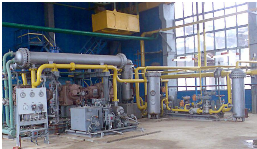
Компрессорная установка топливного газа 2ГМ10-14/13-33С газотурбинной электростанции мощностью 16 МВт. «Концерн Стирол», (Горловка, Украина, 2007). Фильтр «Гриф» - на фото крайний справа. Схема фильтра на 42 фильтрэлемента «Гриф»
