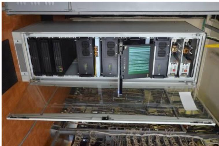
Рисунок 15 – Рабочее место дежурного по станции при микропроцессорной централизации стрелок и сигналов «Ипуть».
