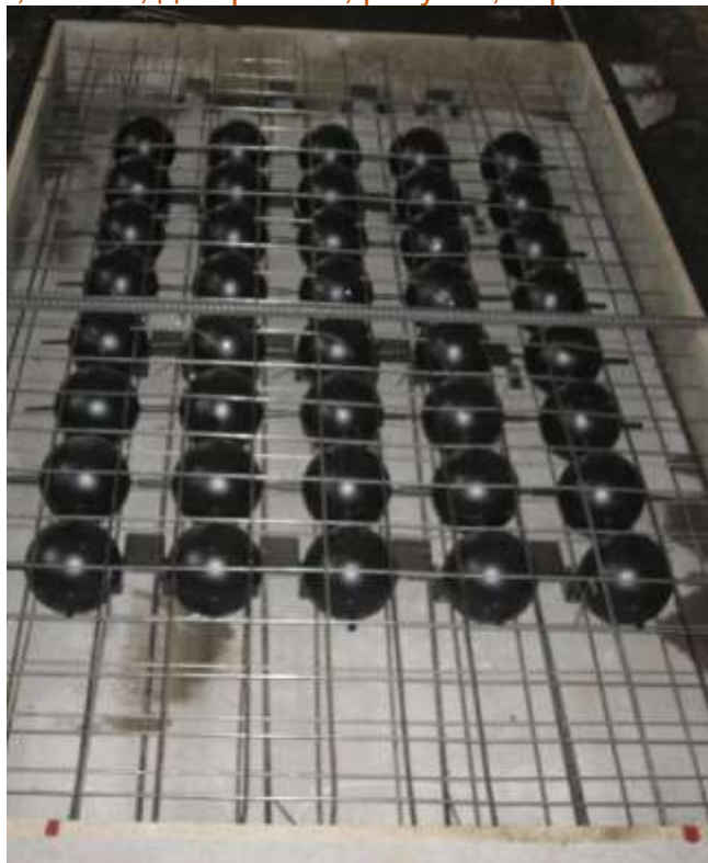
Рисунок 19 –Пустотообразователи с фиксаторами
