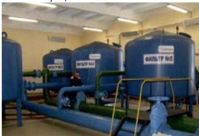
Рисунок 32 – Станция обезжелезивания на РУП «Новогрудское ЖКХ»
