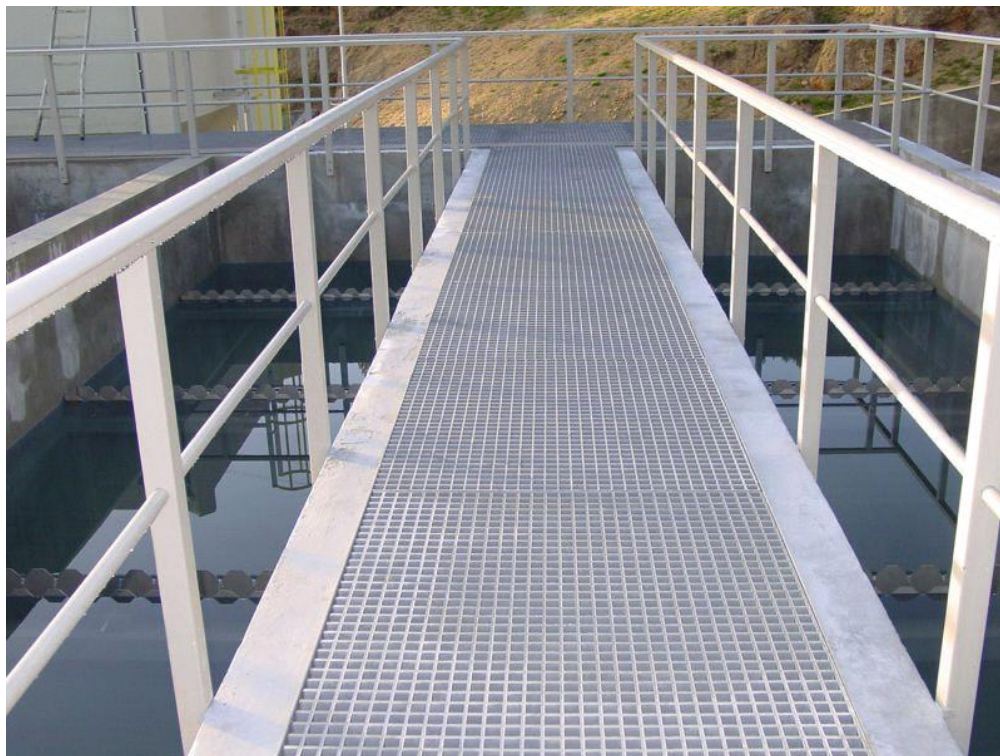
Рисунок 23 – Переходный мостик на очистительной станции
