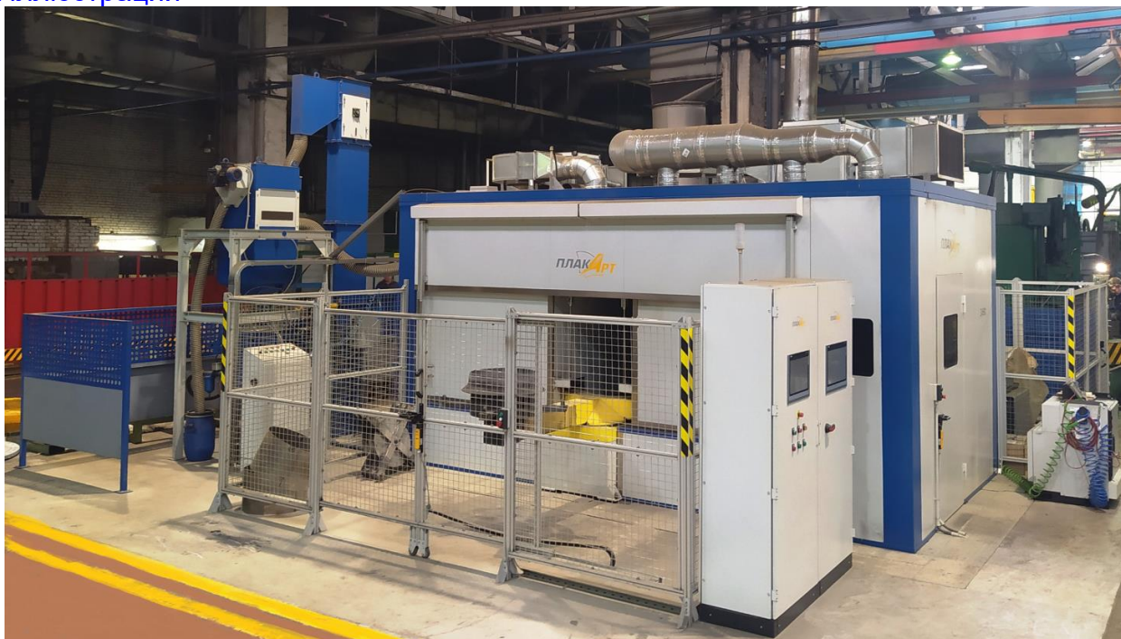
Рисунок 49 – Роботизированный комплекс электродуговой металлизации подманжетных колец редуктора мотор-колеса
