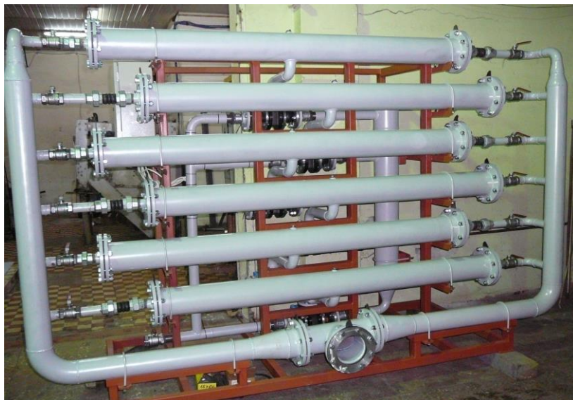
Рисунок 34 – Модульная установка очистки воды для технологических нужд 100 м 3 /ч на ОАО «Белшина»
