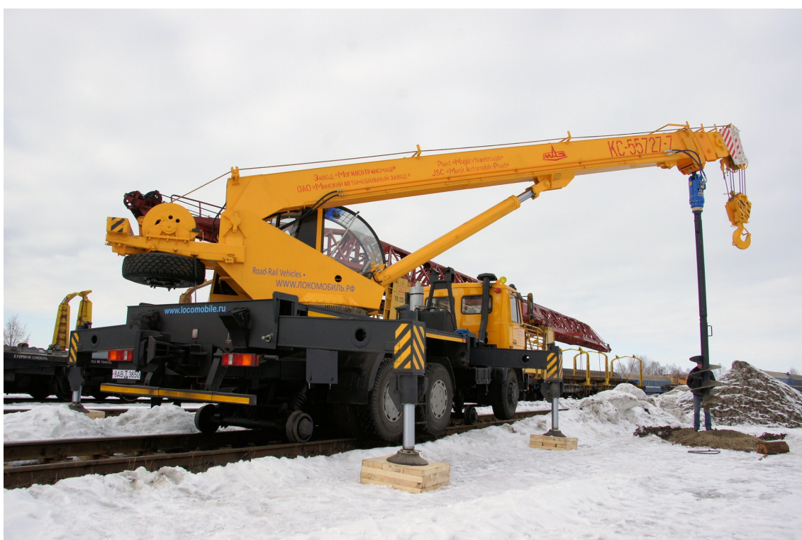
Рисунок 42 – Кран КС-5572 на комбинированном ходу в режиме выполнения маневровых работ и бурения скважин
